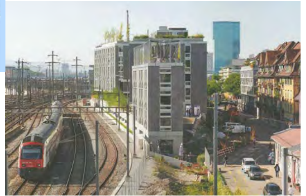
Wohn- und Gewerbebau Zollhaus, Zürich, Enzmann Fischer Partner AG Architekten BSA SIA ETH
