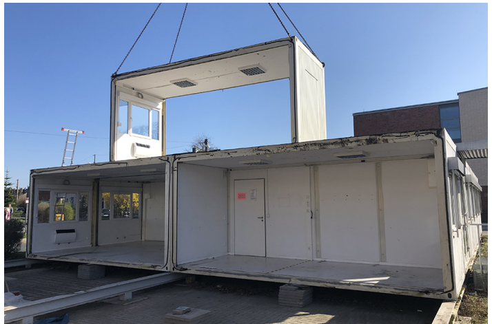
Die vier mobilen Einheiten neben der Schulmensa wurden abgebaut. / Foto: Stadt Sehnde
