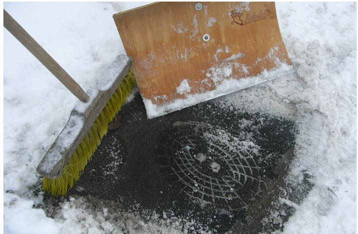
**Wenn Unterflurhydranten freigeräumt sind, kommen die Feuerwehrkräfte schnell an das benötigte Löschwasser.**
