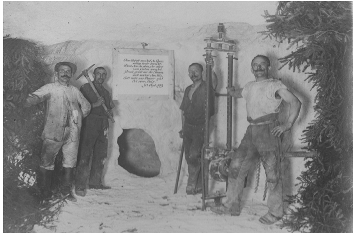
Durchbruch zwischen den Kaliwerken "Riedel" in Hänigsen und "Niedersachsen" in Wathlingen am 30. September 1913.
