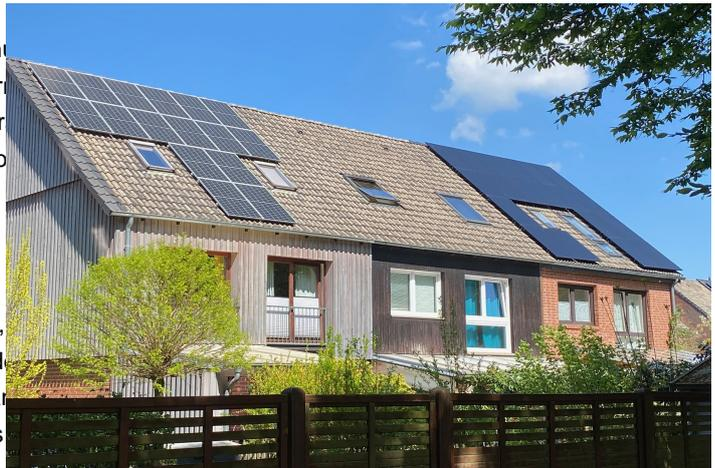
Typische Reihenhäuser in Isernhagen. Auf dem rechten und linken Reihenendhaus ist jeweils eine Photovoltaik-Anlage montiert. Mit der neuesten Bauordnung darf ab sofort eine Photovoltaik-Anlage bis zur Dachkante des Gebäudes montiert werden.
